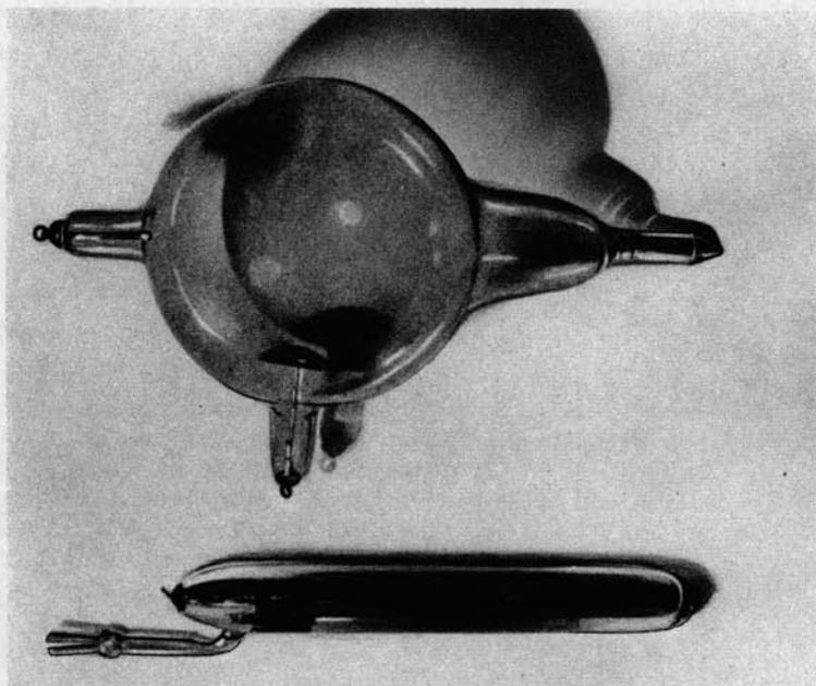
Bild 2. Zwei von den Röhrentypen, die Röntgen bei den ersten Versuchen verwendete.
